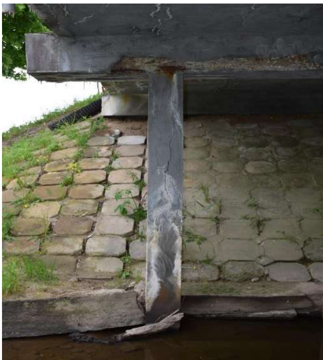
11 pav. Taurų konstrukcijos sutrūkinėjusios, nubyrėjęs tinkas
