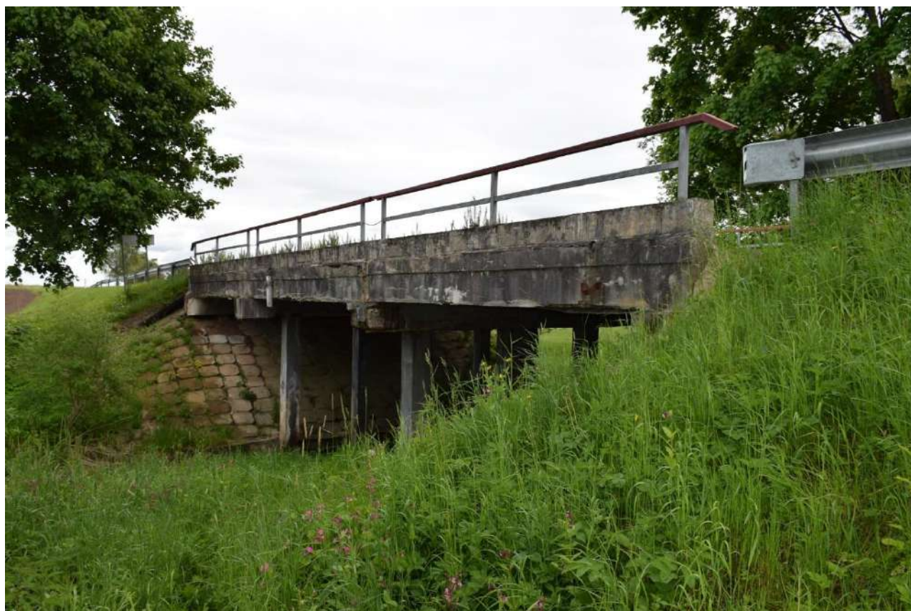
3 pav. Statinio fasadas (aukštupio pusė)
