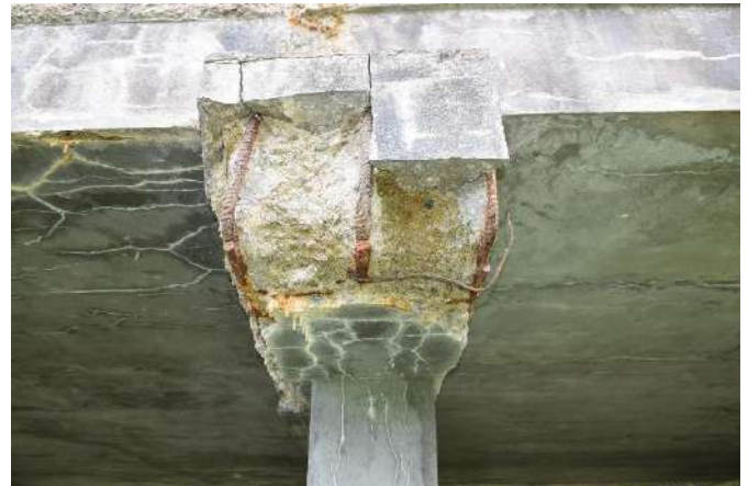
6 pav. Remonto metu padengtas tinko sluoksnis – nubyūrėjęs. Atsidengusi be apsauginio betono sluoksnio likusi sukorodavusi armatūra. Matosi prasiskverbę iš cemento išplauti kalcio karbonatai.
