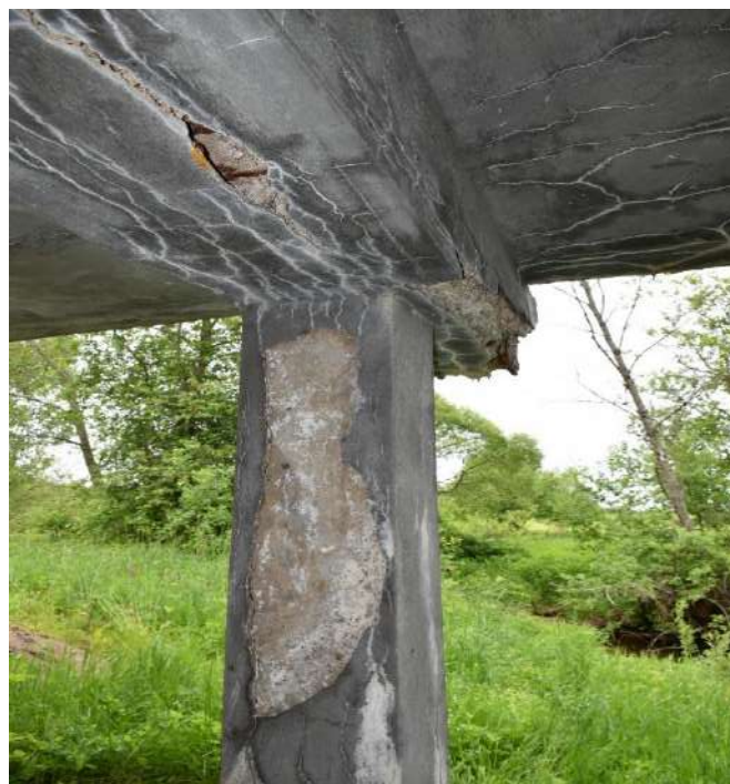
11 pav. Taurų konstrukcijos sutrūkinėjusios, nubyrėjęs tinkas
