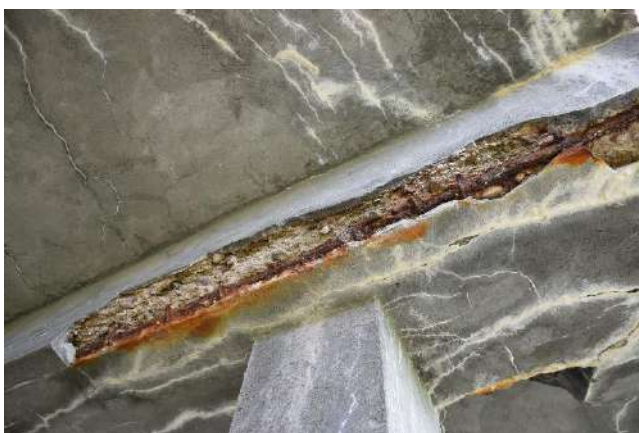
7 pav. Remonto metu padengtas tinko sluoksnis – nubyūrėjęs. Atsidengusi be apsauginio betono sluoksnio likusi sukorodavusi armatūra. Dėl tinkamai nefunkcionuojančios hidroizoliacijos pro apsauginį tinko sluoksnį matosi prasiskverbę iš cemento išplauti kalcio karbonatai.
