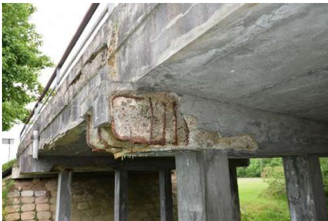
6 pav. Remonto metu padengtas tinko sluoksnis – nubyūrėjęs. Atsidengusi be apsauginio betono sluoksnio likusi sukorodavusi armatūra. Matosi prasiskverbę iš cemento išplauti kalcio karbonatai.
