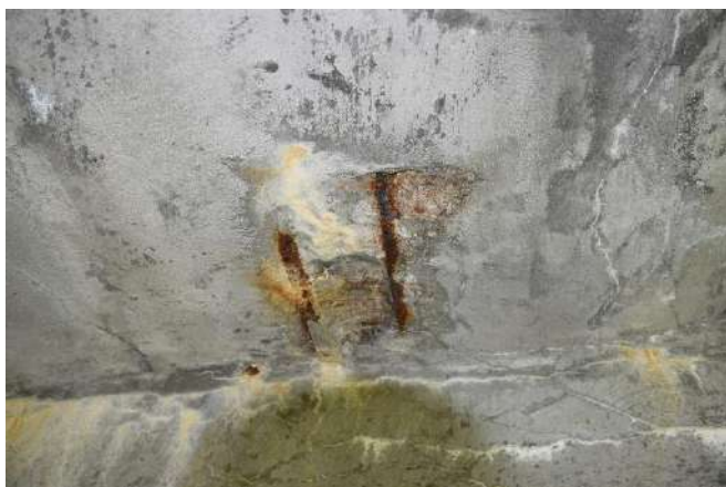
4 pav. Pažeistas apsauginis betono sluoksnis, armatūra koroduoja, iš betono išplauti kalcio karbonatai
