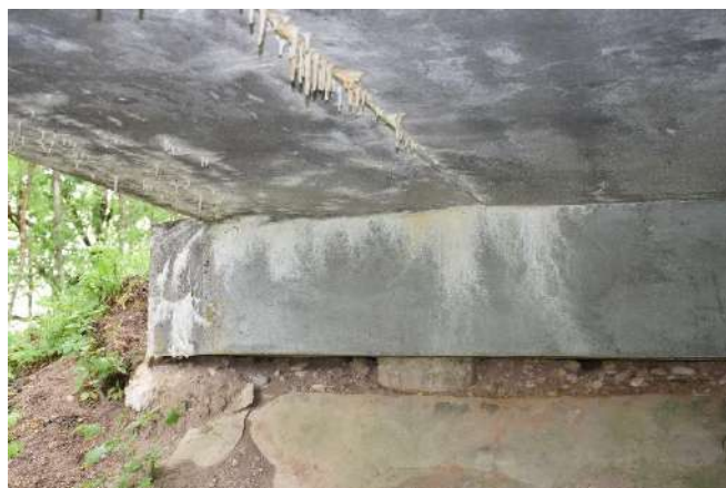
4 pav. Pažeistas apsauginis betono sluoksnis, armatūra koroduoja, iš betono išplauti kalcio karbonatai
