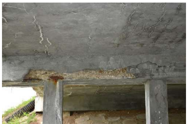
7 pav. Remonto metu padengtas tinko sluoksnis – nubyūrėjęs. Atsidengusi be apsauginio betono sluoksnio likusi sukorodavusi armatūra. Dėl tinkamai nefunkcionuojančios hidroizoliacijos pro apsauginį tinko sluoksnį matosi prasiskverbę iš cemento išplauti kalcio karbonatai.
