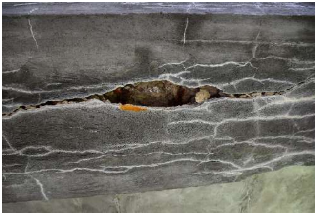
8 pav. Dėl tinkamai nefunkcionuojančios hidroizoliacijos pro apsauginį tinko sluoksnį matosi prasiskverbę iš cemento išplauti kalcio karbonatai. Artimiausiu metu nubyrės ir labiausiai pažeistos tinko sluoksnio vietos
