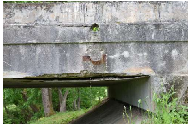
8 pav. Dėl tinkamai nefunkcionuojančios hidroizoliacijos pro apsauginį tinko sluoksnį matosi prasiskverbę iš cemento išplauti kalcio karbonatai. Artimiausiu metu nubyrės ir labiausiai pažeistos tinko sluoksnio vietos
